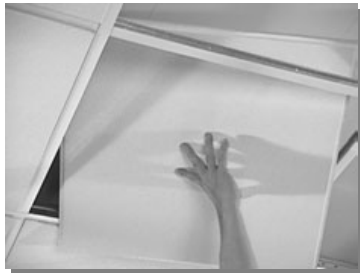
Incline los plafones – encima del marco y bájelos a su lugar
