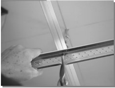
Instale las "T" secundarias del borde
