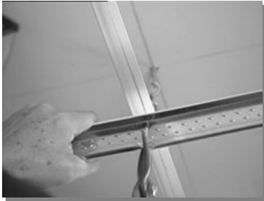
Instale las "T" secundarias del borde
